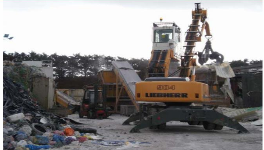
3 broyeurs à couteaux (160, 60, 30 mm) en ligne avec brumisateurs pour neutraliser l'aspect pulvérulent (étage à 60 mm à priori inutile sur les composites cassants)
